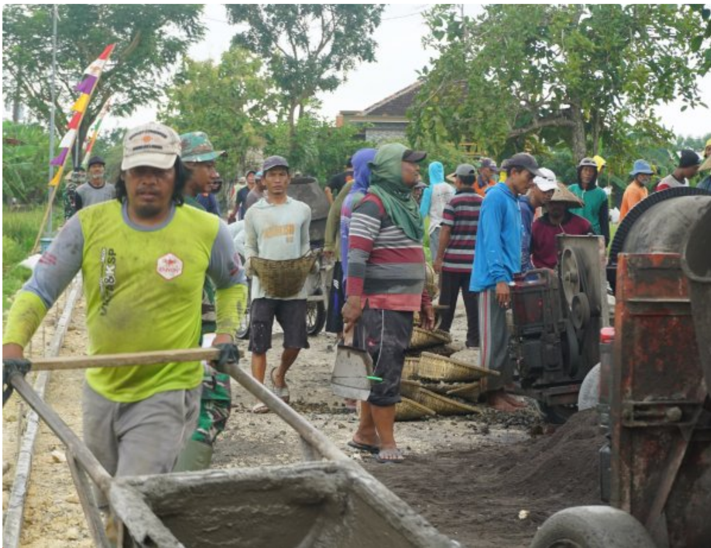
Warga Desa Bandungrejo, Karanganyar, Demak, Berbondong-bondong Bantu Dalam Pengecoran Jalan TMMD
