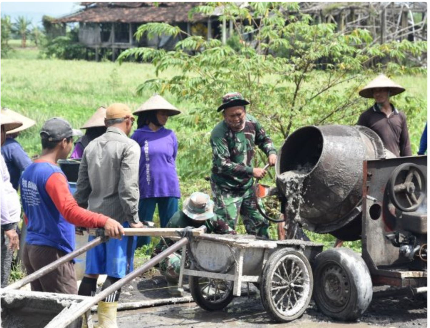
TNI dan Warga Desa Bandungrejo kebut pengecoran jalan dalam TMMD Reg 123
